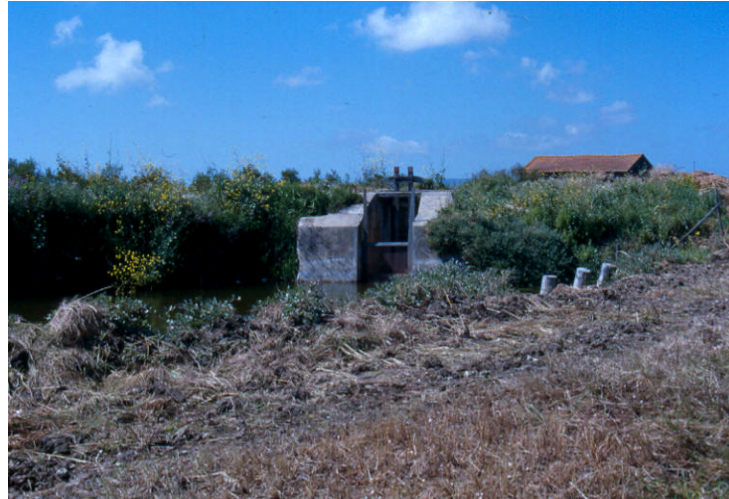
Figure 5 - The greiro of Corredor da Cobra saltworks
