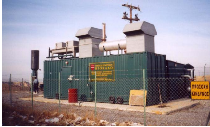
Η μονάδα συμπαραγωγής με αέριο χωματερής στους Ταγαράδες
