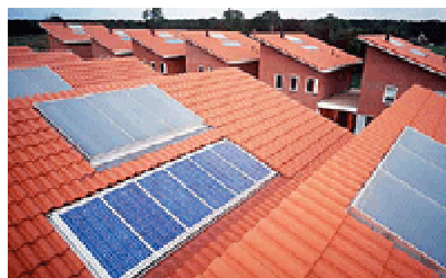
Ενσωμάτωση φωτοβολταϊκών σε στέγες κτιρίων
