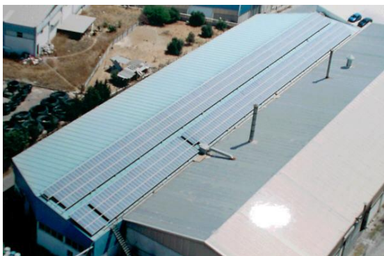
Εφαρμογή φωτοβολταϊκών σε στέγη εργοστασίου στην Κρήτη
