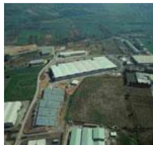
Αεροφωτογραφία του εργοστασίου στα Οινόφυτα Βοιωτίας όπου έχει εγκατασταθεί σύστημα ηλιακού κλιματισμού. Εδώ, φαίνεται το πεδίο επίπεδων ηλιακών συλλεκτών.
