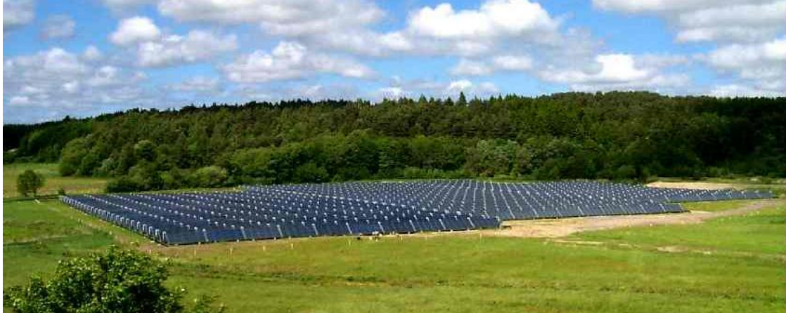
Ηλιοθερμικό σύστημα για τηλεθέρμανση στη Σουηδία
