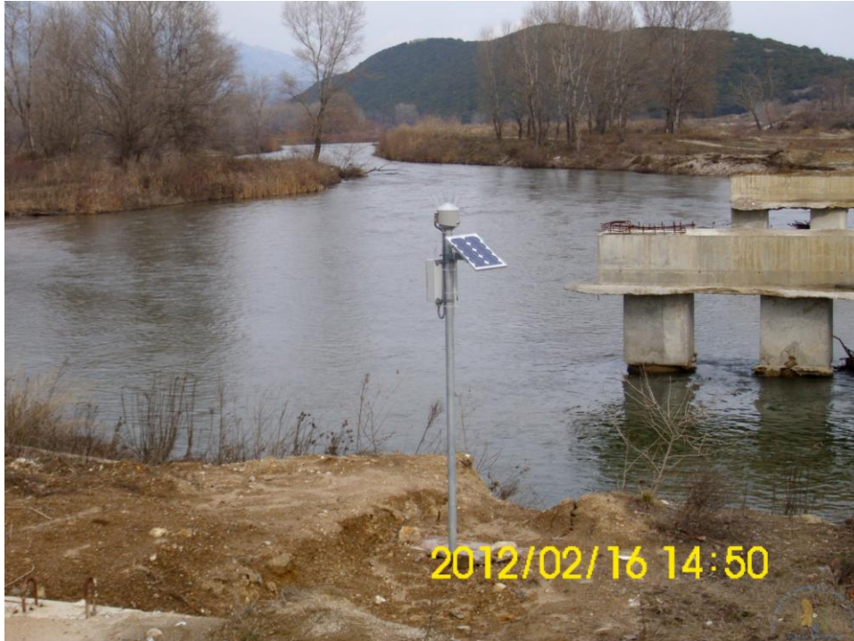
Εικόνα 5. Τηλεμετρικός σταθμός Ποταμού Νέστου
