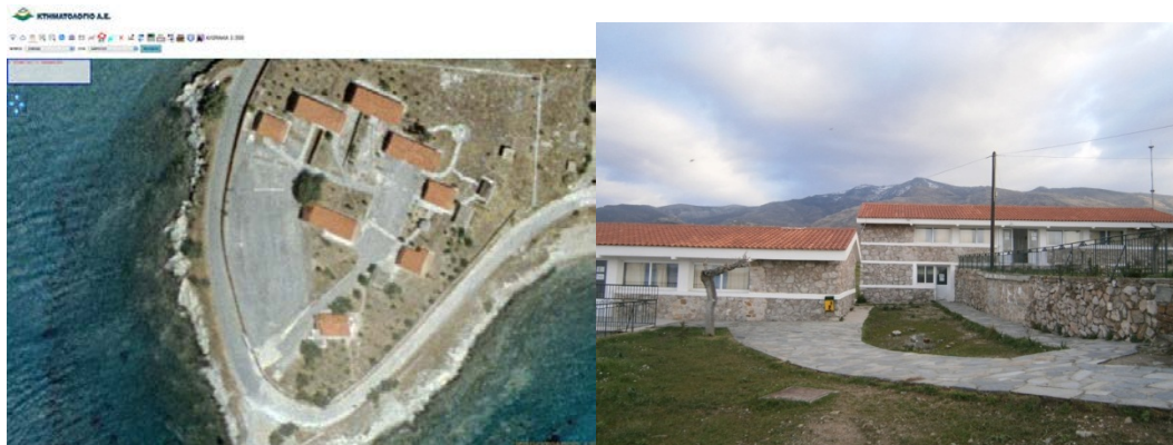
Εικόνα 7: Σκεπές του σχολείου για την εγκατάσταση ηλιακών πάνελ και φωτοβολταϊκών.
