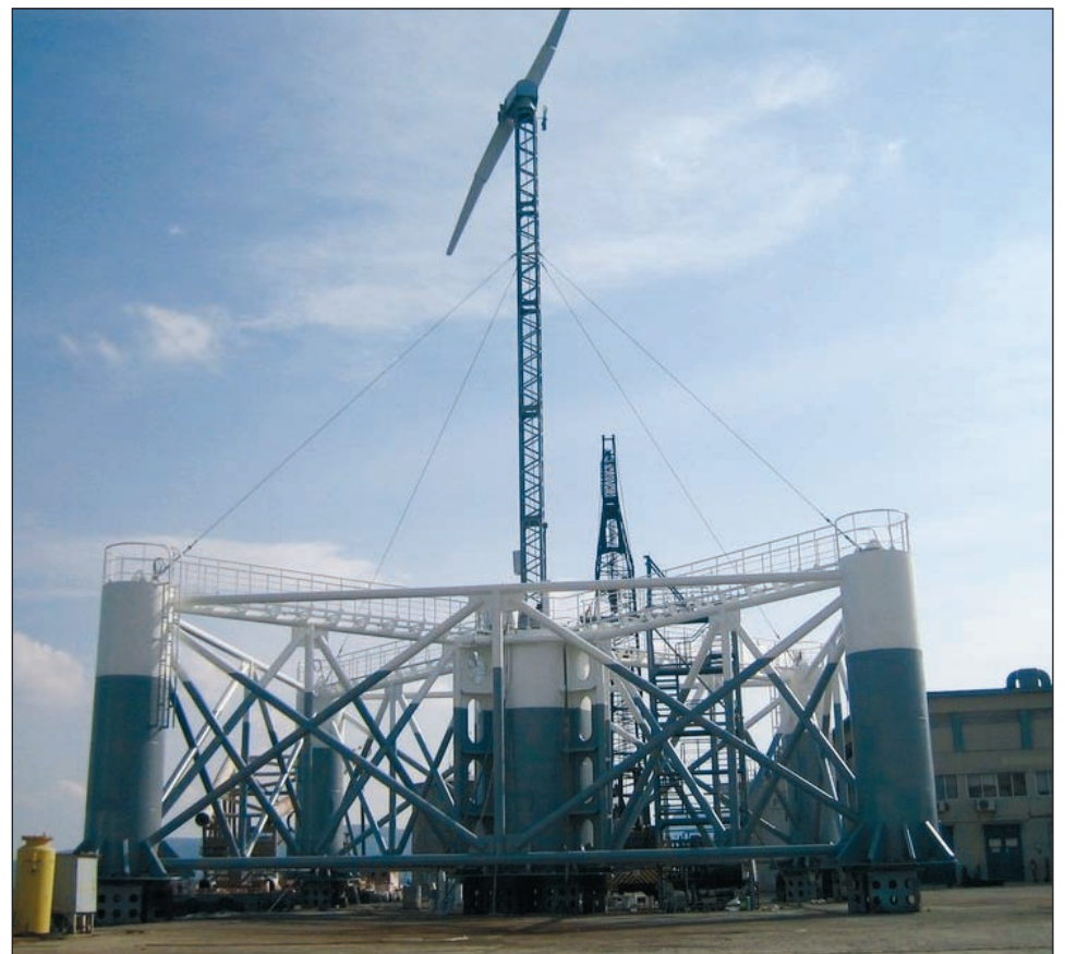
Πλωτή ανεμογεννήτρια στο ναυπηγείο
